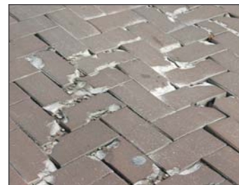
Schon von weitem erkennt man die Schäden an den Klinkersteinen im Bereich Kreuzung Dellenberg/Hafenstraße. Aus der Nähe betrachtet (Foto links) zeigt sich ganz deutlich, dass der Klinker nebst Untergrund nicht für Schwerlastverkehr geeignet ist. Fotos Stoltenberg.
