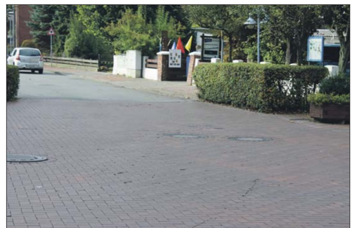
Schon von weitem erkennt man die Schäden an den Klinkersteinen im Bereich Kreuzung Dellenberg/Hafenstraße. Aus der Nähe betrachtet (Foto links) zeigt sich ganz deutlich, dass der Klinker nebst Untergrund nicht für Schwerlastverkehr geeignet ist. Fotos Stoltenberg.
